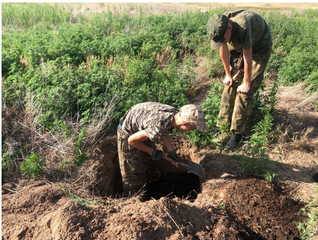
Фото 46. Возведение одиночного окопа для положения стрельбы «сидя»
